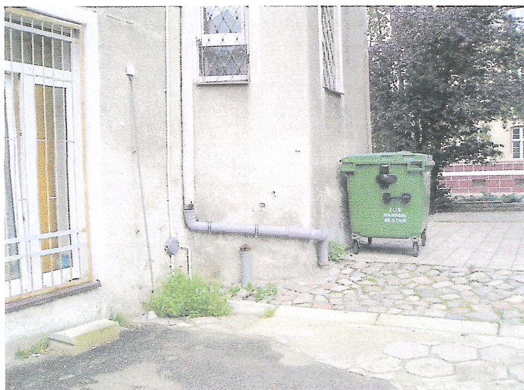
Przejęcie rury spustowej w poziom – do przeniesienia
