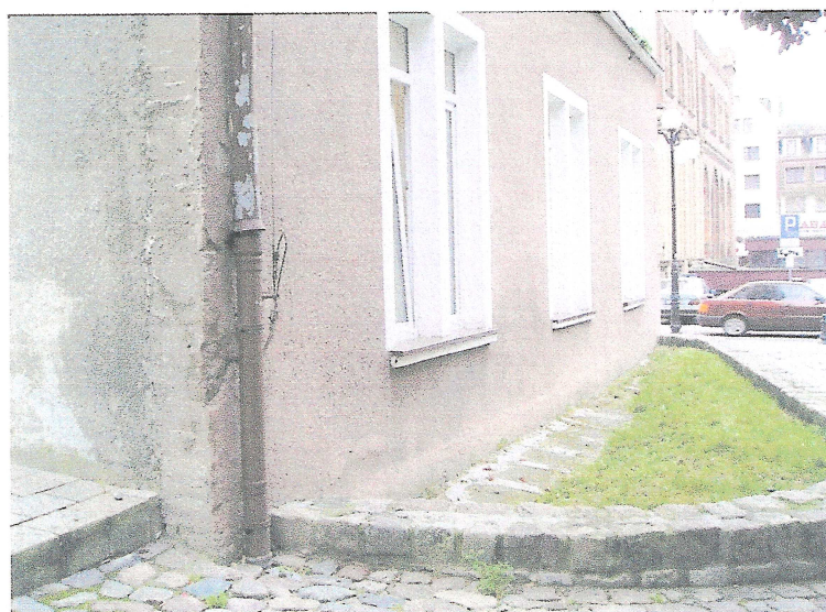
Widok ściany od strony ul. Ratuszowej – nowa izolacja ściany piwnic
