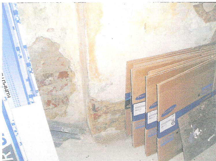
Widok ściany od wewnątrz od strony ul. Ratuszowej – wymiana tynku
