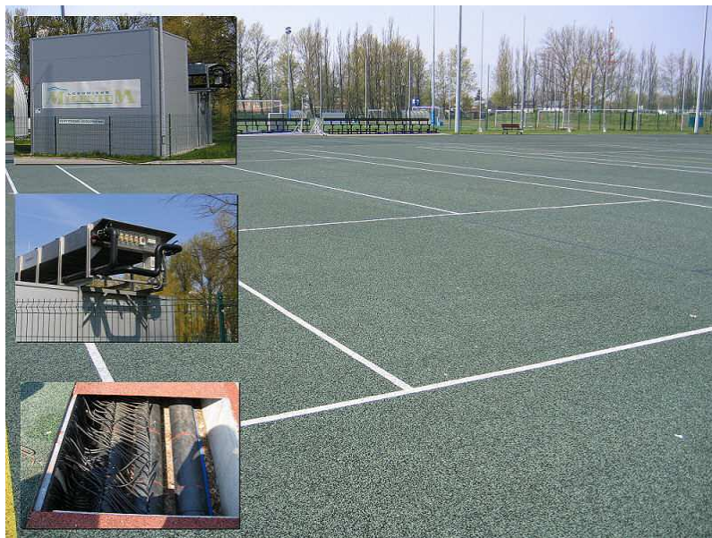
Rysunek 7: Pompa ciepła na terenie kompleksu Milenium w Kołobrzegu
