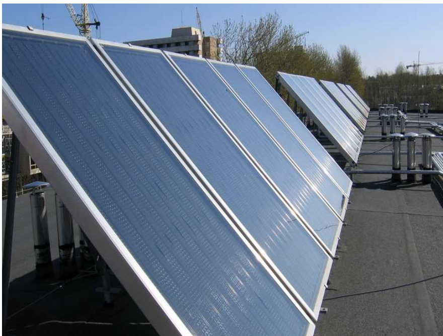
Rysunek 8: Kolektory słoneczne na dachu budynku Wyższej Szkoły Przedsiębiorczości i Zarządzania, Wydział Zamiejscowy w Kołobrzegu
